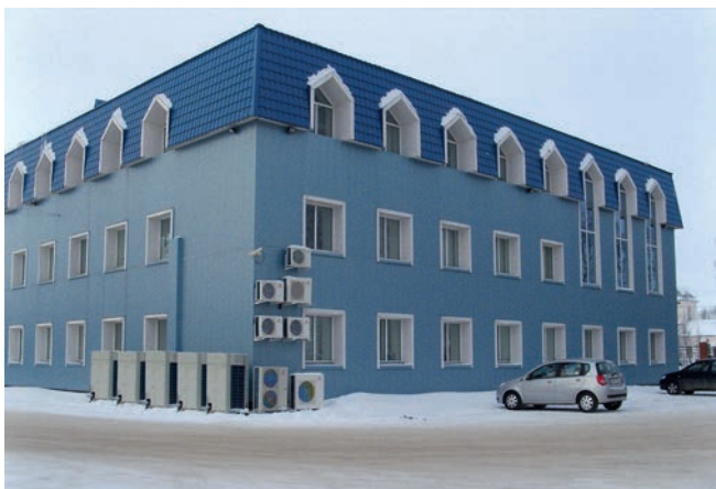
Офисный центр г. Сыктывкар Мультизональные системы Dantex
