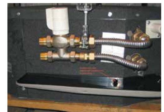
Поддон для сбора конденсата (внешний) и запорно-регулирующий узел смонтированы на кассетном фанкойле
